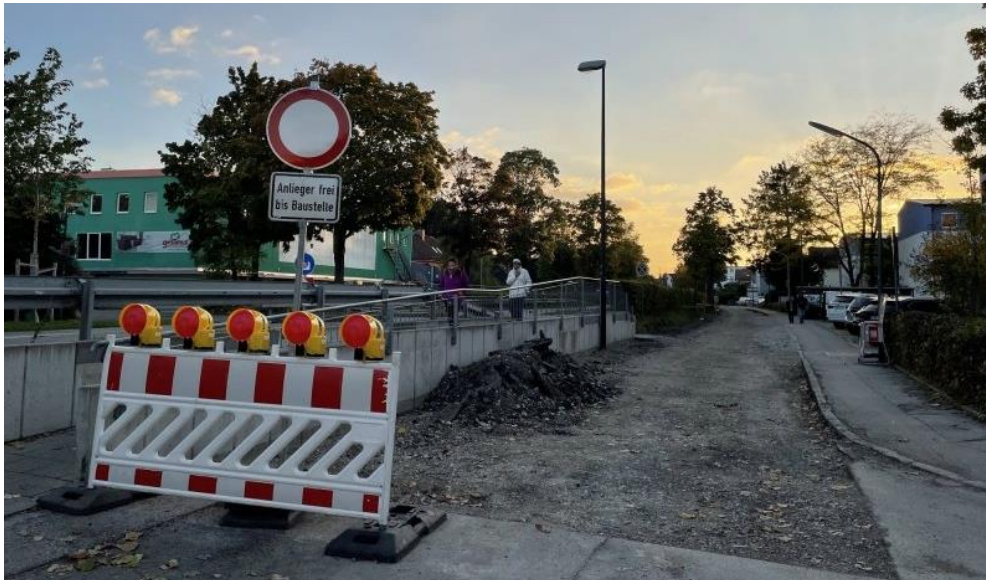
Abbildung 6: Die Baustelle der neuen Fahrradstraße entlang der Landsbergerstraße. Quelle: Parsberg Echo (12.10.2021); https://www.5-seen-wochenanzeiger.de/germering/vorfahrt-fuer-radler,136957.html
